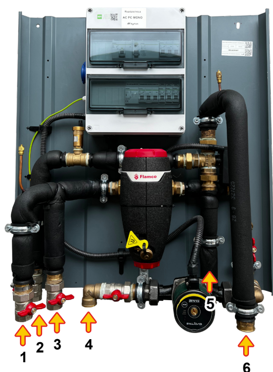
Rys. 7 Schemat podłączenia hydraulicznego
